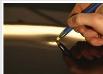
Mark the center of the dent Zentrum der Delle markieren
